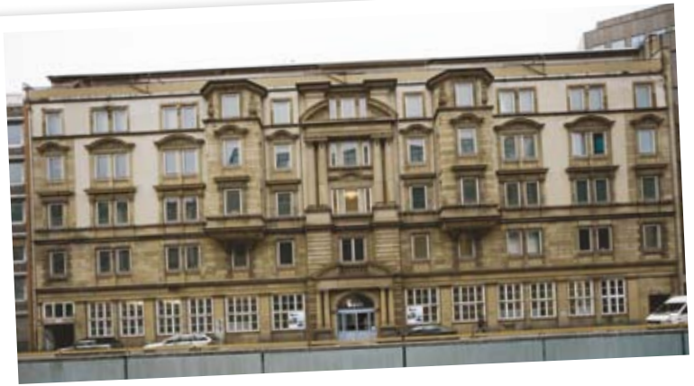
basis 2, Gutleutstraße 8-12, Frankfurt am Main
